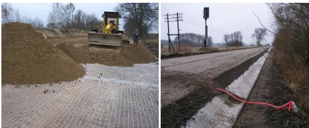
Abbildung 2.2-2 Bauvorhaben Gleiserneuerung Casekow - Tantow, Einbau der geokunststoffbewehrten Tragschicht im Moorbereich 1.1
