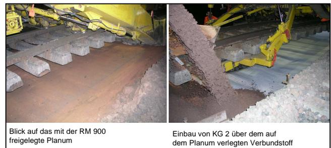
Abbildung 2.3-2 Bauvorhaben POS Nord, Einbau der Schutzschicht im Bereich km 24,850 - km 25,050
